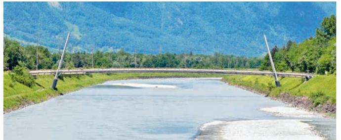
Bei der 2009 zwischen Buchs und Schaan erstellten Brücke handelt es sich um eine Hängekonstruktion mit Fernwärmeleitung, dank welcher jährlich rund 12–15 Millionen Liter Öl eingespart werden können.
